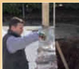
Lissage, pose du rail et mise en place de la margelle
