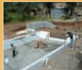
Réalisation du radier et des murs
